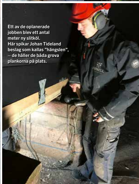
Det krävs en del säkerhetsarbeten också, som skyddsnet under landgången.
