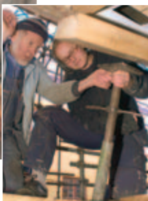
Paul Rönnblom och Lena Orring sätter spänt för att stötta plankan när den ska tvingas på plats, (Bilden t. v.)
